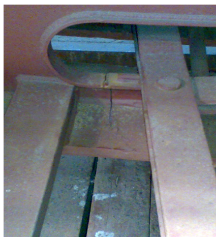
Рис. 8. Фото руйнування конструкції платформи, при випробуваннях на опір втомі, у зоні вікна горизонтального важеля хребтової балки
